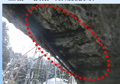
主桁の損傷（鉄筋露出）
