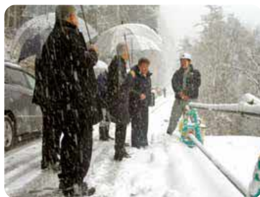
五條市 中原工区の道路改良状況
